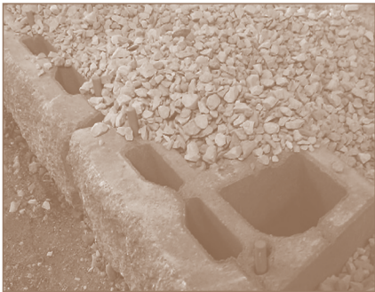
Diagram 7—Backfill and Fill Cores
